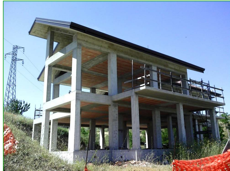
Realizzazione della struttura in c.a.
